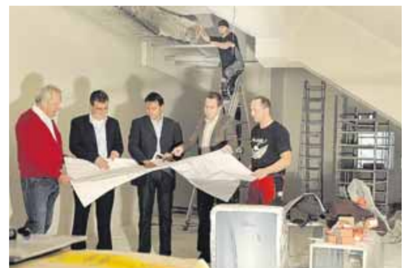
Alles nach Plan läuft derzeit bei den Umbaumaßnahmen in der Impuls-Arena. Unser Bild zeigt von links die Handwerker Alois Müller, Joachim Uhlherr, Architekt Dieter Keller, Stadionchef Michael Ströll und Holger Böhner in den Katakomben der Arena.
