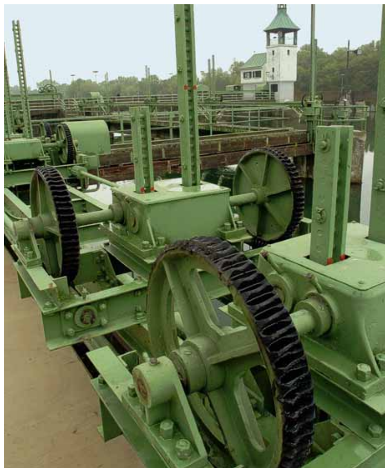
Der Hochablass soll künftig Strom liefern. Zu sehen sein wird das geplante Wasserkraftwerk allerdings nicht. Die Stadtwerke bauen es unterirdisch auf der Seite des Kiosks ein. Foto: Silvio Wyszengrad
