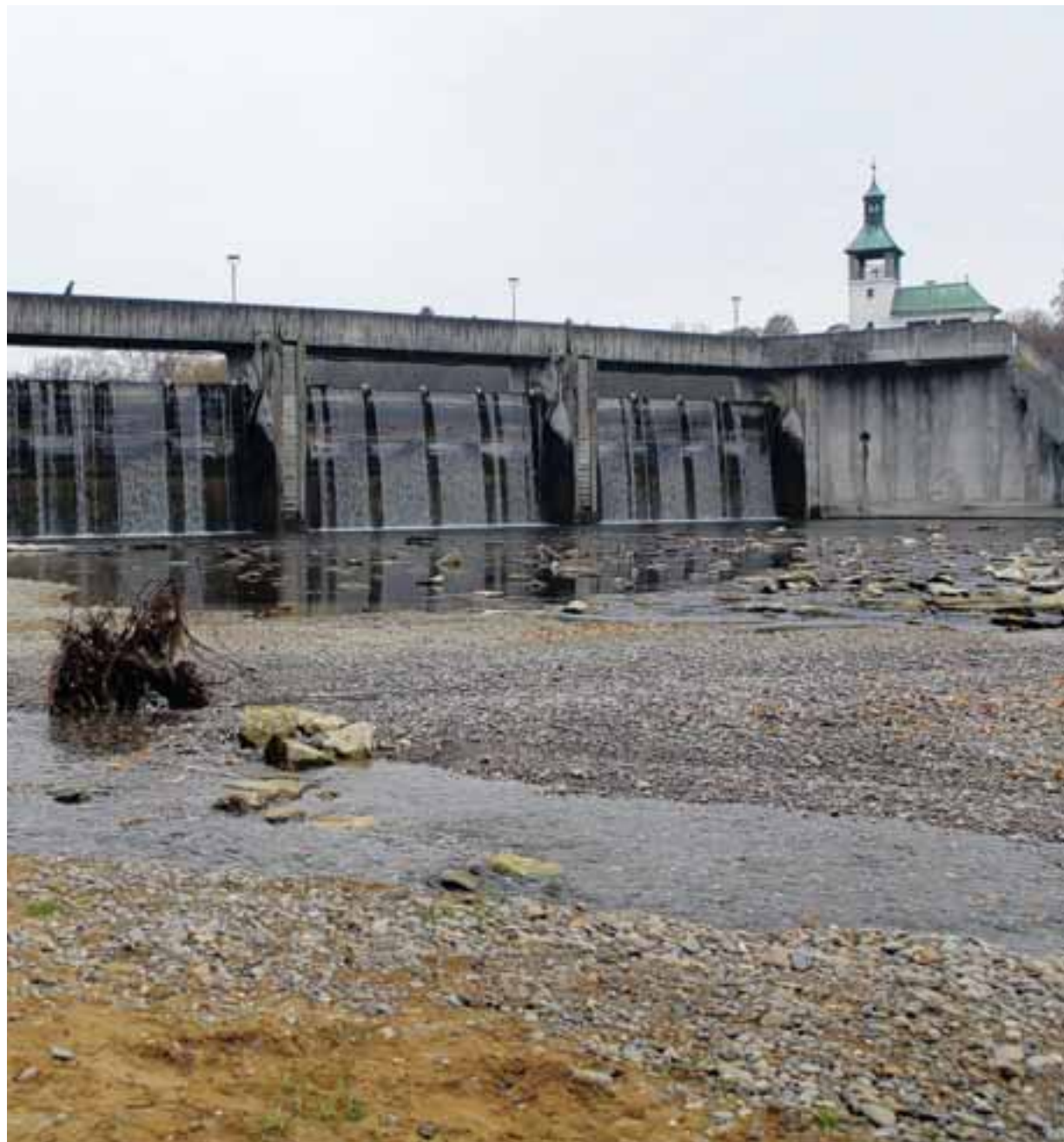
Das geplante Wasserkraftwerk könnte den Hochablass trockenlegen. Über die Wehrmauer beziehungsweise die Wehrfelder (wie in den drei Bereichen rechts) würde dann kein Wasser mehr fließen, es ginge durch die Turbinen. Foto: Michael Hochgemuth
