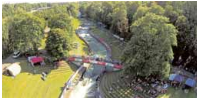
Die Kanuslalomstrecke am Eiskanal ist 300 Meter lang. Beim ICF Weltcup-Finale sind dort rund 200 Freiwillige im Einsatz.
